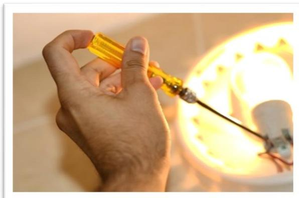
Se utilizado da maneira correta, o chuveiro elétrico não oferece grandes riscos. Porém, fazer qualquer reparo ou checagem no equipamento sem ter desligado a energia da casa é perigosíssimo.
